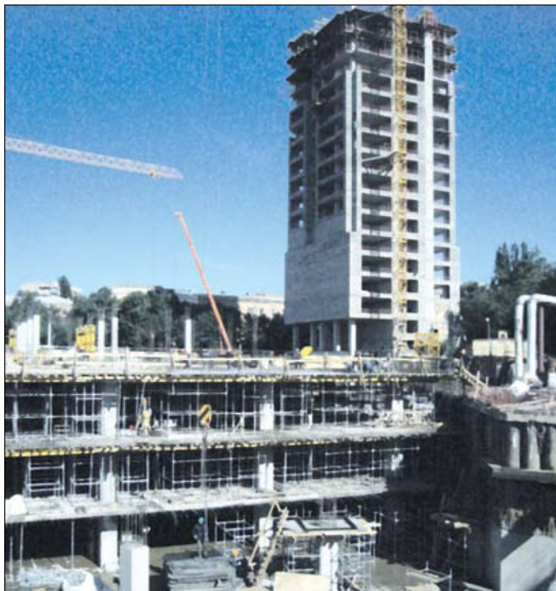
Строительство с помощью свайно-монолитной конструкции подразумевает использование буронабивных свай, глубина которых достигает 17,5 метра (для сравнения – сваи жилых домов в среднем достигают 5-7 метров)
