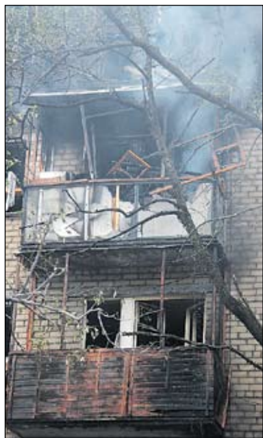
В доме, во дворе которого стоял склад, стекла были выбиты со всех сторон
