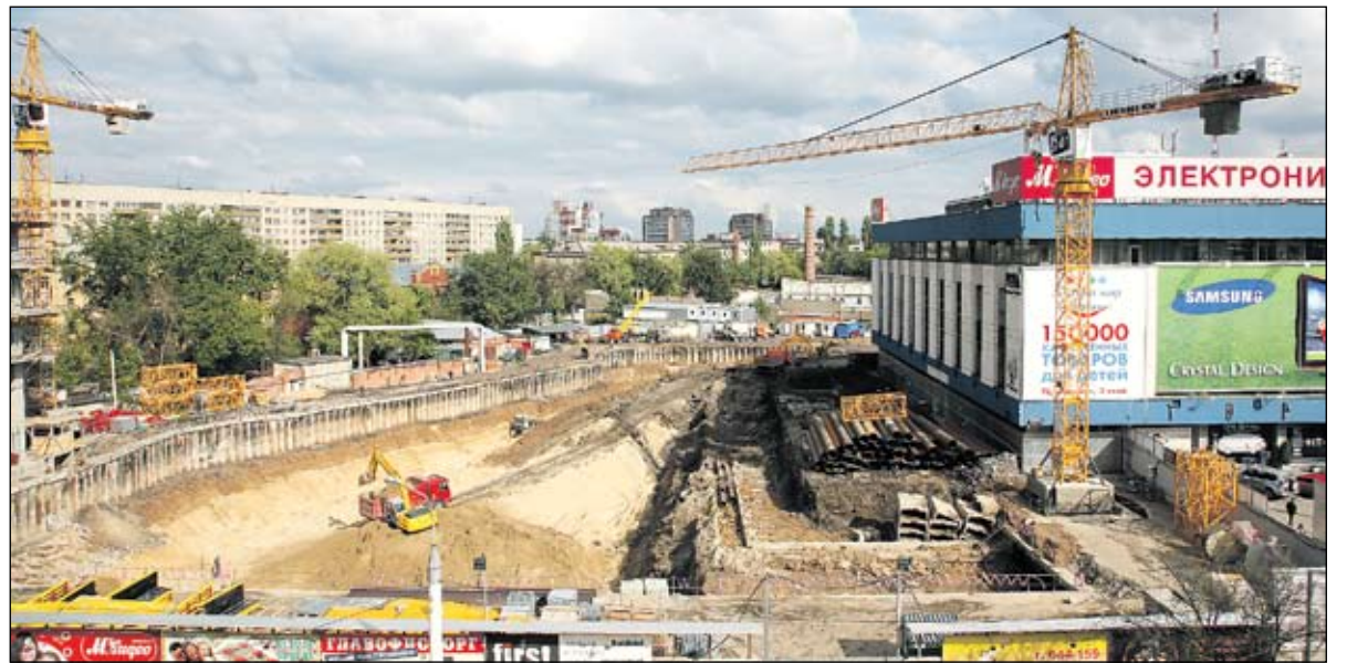
Весь процесс строительства ТДК - от закладки фундамента до последних отделочных работ - можно назвать образцом применения самых современных строительных технологий
