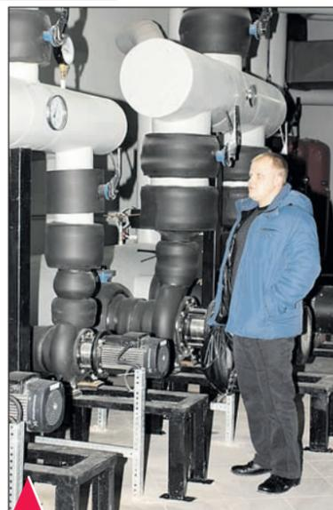
Охлаждение водяных и воздушных систем Центра обеспечивается 4 чиллерами. Отопление осуществляется при помощи радиаторов, вентиляции и фанкойлов. Вся система регулируется в дистанционном и ручном режимах.
