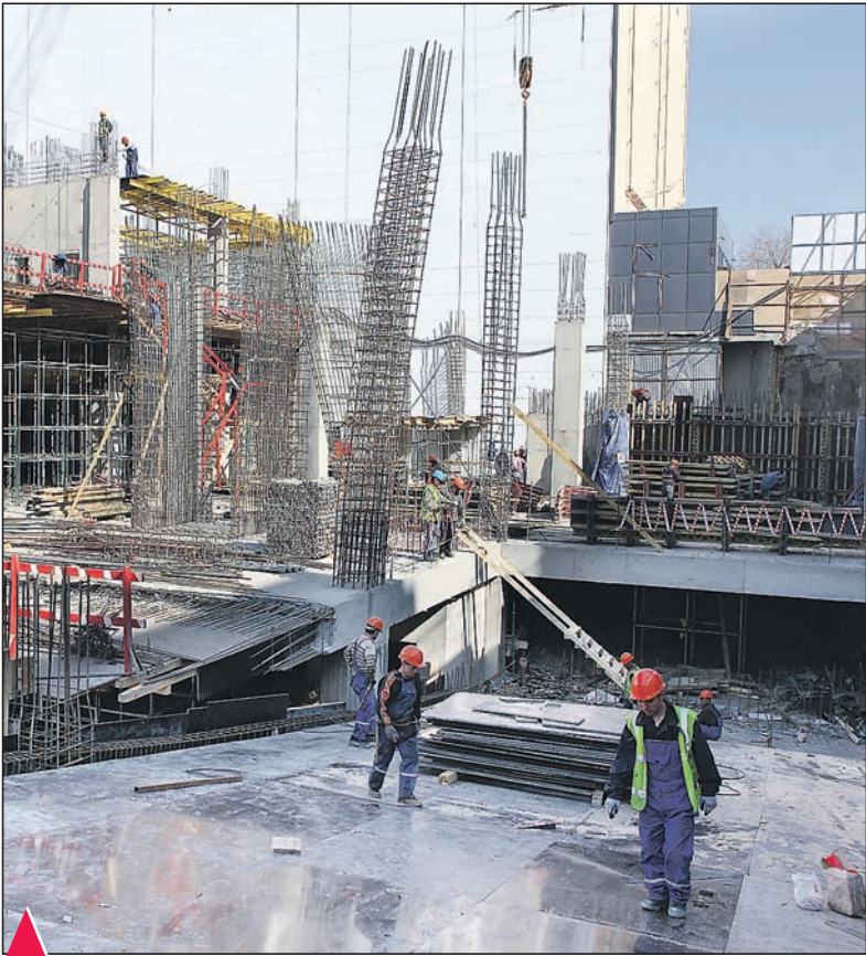
Завершаются работы по въезду на парковку - 3 этажа Второй очереди
