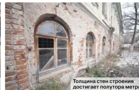
Толщина стен строения достигает полутора метра
