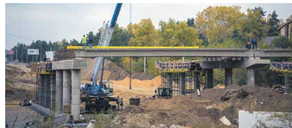
Строительство развязки на перекрестке улиц Антонова-Овсенко, 9 января и Героев Сибиряков закончится уже в следующем году
