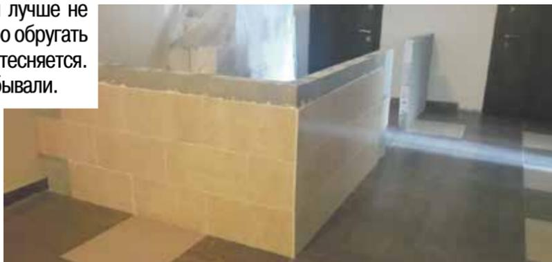
Жилец одной из квартир воздвиг кладовку, отгородив для этого металлической стенкой половину лестничной клетки на этаже, заодно перекрыв общее окно и батарею отопления
