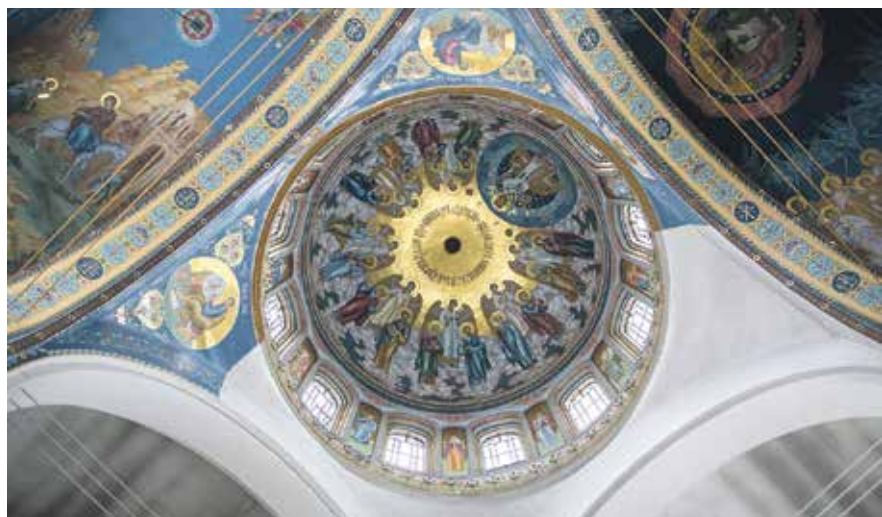
По периметру купола расположен небольшой выступ, чтобы служащий храма мог добраться туда и заменить лампы
