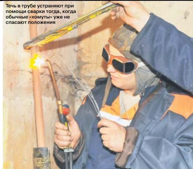
Течь в трубе устраняют при помощи сварки тогда, когда обычные «хомуты» уже не спасают положения
