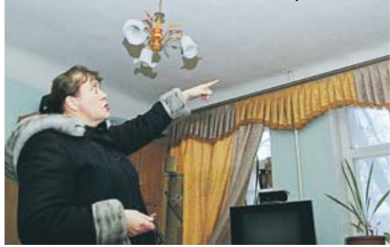
Грязное пятно на потолке становится причиной постоянного косметического ремонта
