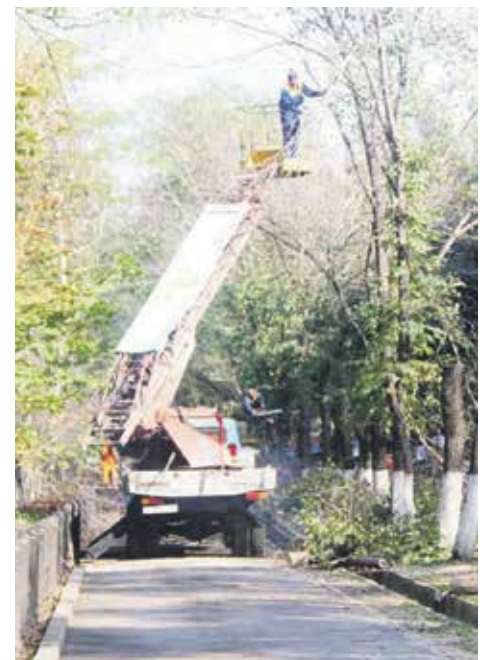
Правилами благоустройства территорий округа установлено, что за зелеными насаждениями должен выполняться уход, в том числе обрезка и удаление сухих и аварийных ветвей и стволов деревьев и кустарников
