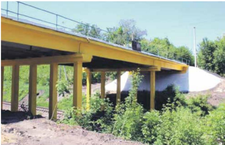
Дорожники проверили опоры пролетных строений и сопряжения мостов с насыпью, ликвидировали сквозные проломы, восстановили гидроизоляцию полотна, заменили деформационные швы и отремонтировали тротуары. Для обеспечения безопасности движения установили барьерные ограждения.
