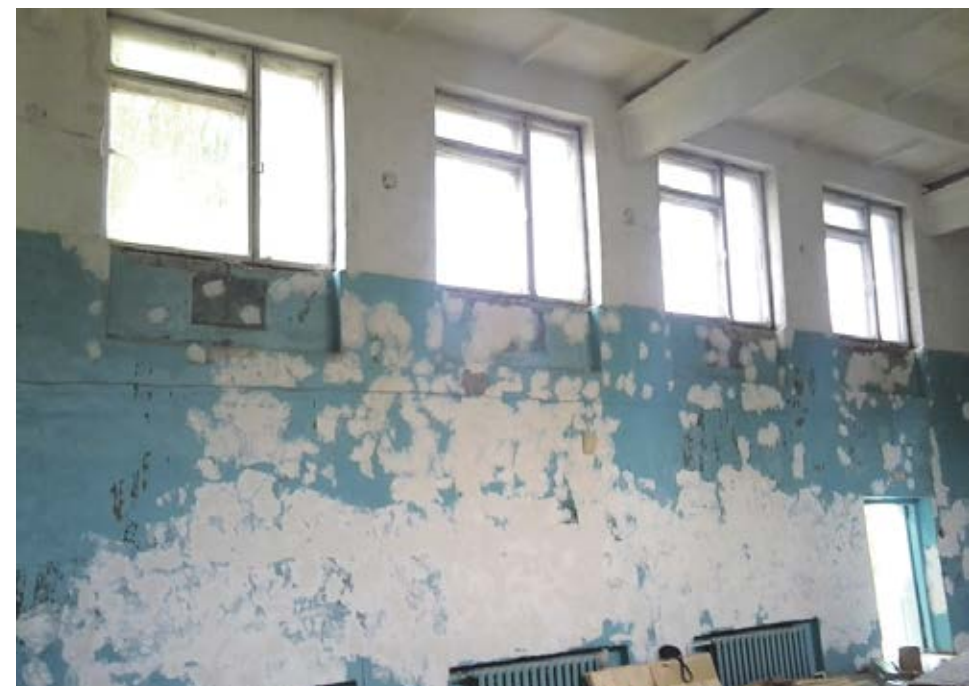
Колбинская СОШ до ремонта
